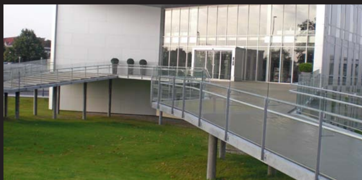
Kombineret trappe og rampe foran Roskilde Rådhus er et eksempel på et byggeri udført med elementer, som ellers skulle være støbt in-situ. Elementløsningen betød et hurtigere og billigere byggeri og en meget bedre kvalitet.
