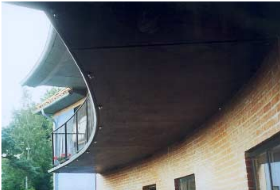
CRC balcony slabs at Løngangsgade, Hillerød, Denmark designed by Arkitekttegnestuen Møllestræde.
